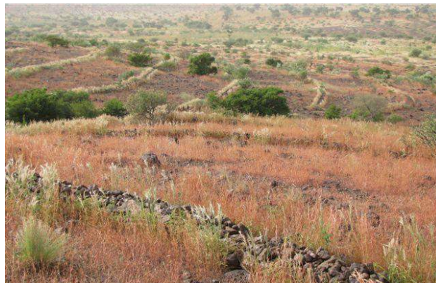
Photo 11 : Ouvrages anti-érosifs sur versants rocaillieux, village de Guidan Bouzou, commune Madaoua. Photo : Iram
